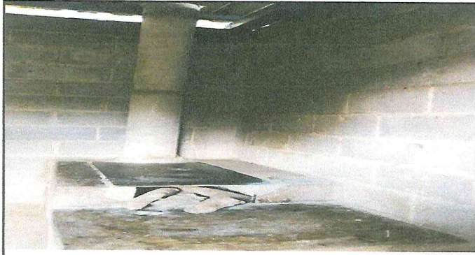
Foto 1: Plancha de 3 hornillas ya sustituidas.
