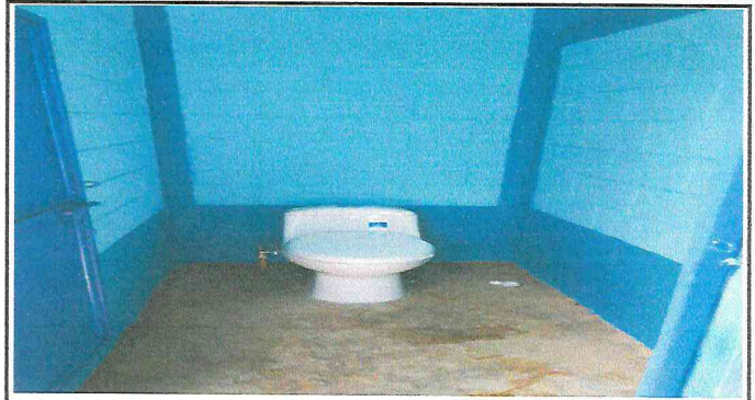
Foto 2: Sanitarios ya sustituidos.
