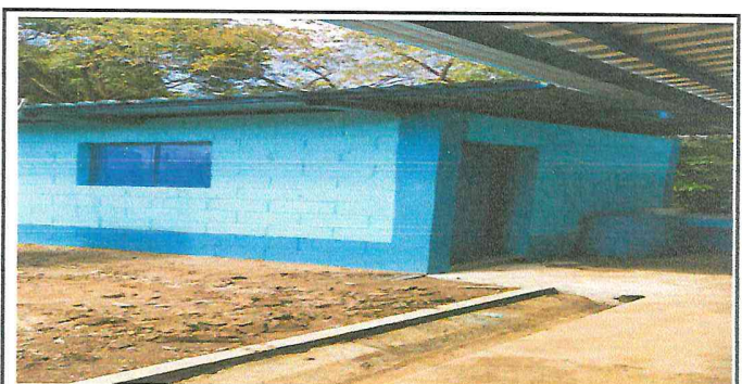
Foto 4: Cocina ya con ventana y puerta nueva.
