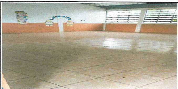
Foto 5: Sustitucion de piso ya finalizado
