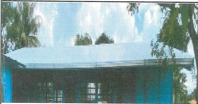
Foto 3: Canales ya colocados.
