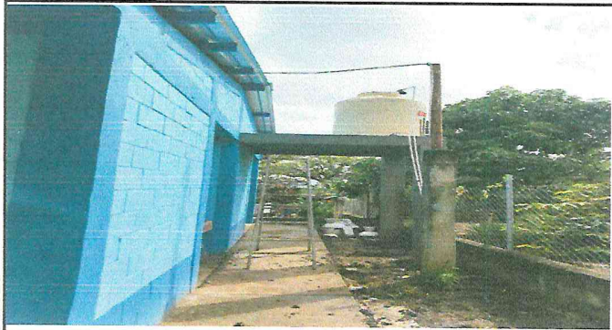
Foto 1: Base de tinaco terminada.
