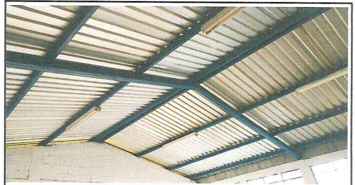
Foto 4: Cambio de lamina y mantenimiento de costaneras terminado.
